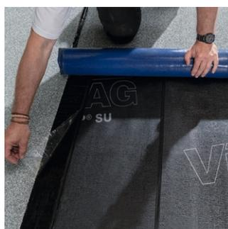
Ab zweiter Bahn: Längsrandstreifen in Richtung der Bestreuung lösen und abziehen.
