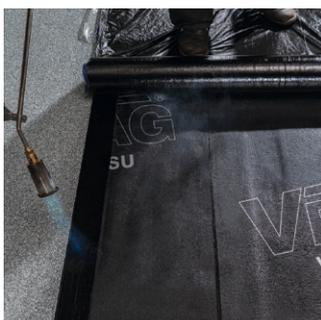
Auf die umgeschlagene Unterseitenfolie stellen, die Längsnaht thermisch aktivieren ...
