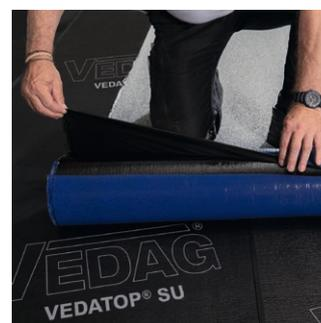
Unterseitenfolie lösen und umschlagen.
