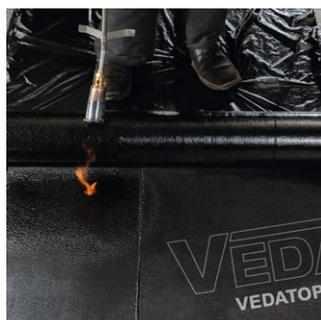
... und dann die Bahn durch gitternetzartiges Aufbrechen der Oberseitenfolie der Unterlagsbahn thermisch aktivieren.
