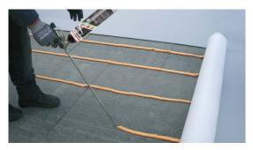
EF TK 400 kann deutlich schneller als herkömmliche, flüssige PU-Klebstoffe mittels Schaumpistole aufgetragen werden. Das bietet vor allem bei niedrigen Temperaturen einen großen Zeitvorteil.
