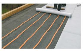
Anschließend wird die vlieskaschierte Dachbahn in den frisch aufgebrachten Schaum eingerollt und mit einem weichen Besen kräftig angedrückt. Bei eventuellem Nachschäumen des Klebstoffs Dachbahn nochmals nachdrücken.
