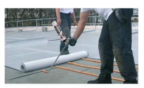
Zur Erzielung einer ausreichenden Klebverbindung zum Untergrund ist je Meter Bahnenbreite ein gleichmäßiger, mind. 3-streifiger Kleber-auftrag mit ca. 3 cm Durchmesser erforderlich.
