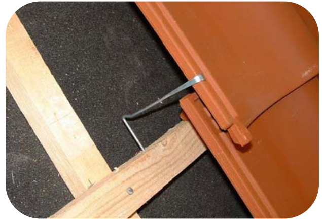
Lapetiilikiinnike kiinnitetään vesilukkosta ruoteeseen.
