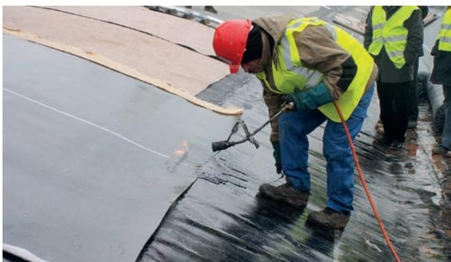
Les recouvrements entre deux lés de géomembrane bitumineuse ont au minimum 20 cm de largeur et les joints sont effectués par soudure au chalumeau alimenté au gaz propane. L'assemblage se fait à l'avancement ou après le positionnement complet des lés. Il est immédiatement suivi d'un marouflage. Un chanfreinage à chaud de la lèvres du joint peut compléter cette opération.
