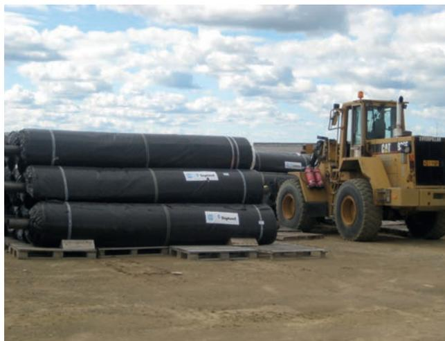
Chaque rouleau nécessite une surface au sol de 4 m<sup>2</sup>. Un camion complet nécessite une surface minimale de 50 m<sup>2</sup> pour le stockage.
