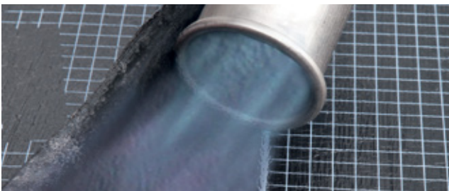
Nach Kaltselfklebung des KSK-Randstreifens erfolgt die Verschweißung. Hinweis: Bei der Dampfsperrebahn Vedagard Safety Plus kann der Nahtverschluss mit dem Brenner erfolgen, muss er aber nicht.
