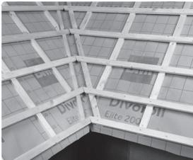
Posez les contre-lattes sur mesure dans la noue et sciez-les parallèlement dans la direction de la noue. Montez les linteaux selon l'écartement correspondant au modèle de tuile qui doit être utilisé. Montez des linteaux d'une longueur suffisante sur la contre-latte du linteau de rive. En cas d'utilisation de tuiles plates, la gouttière de noe doit être posée  $\pm 12\text{mm}$  plus profondément en renouvelant les linteaux de 12mm à l'endroit de la gouttière de noe.
