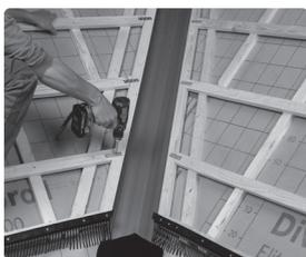
Montez une contre-latte du linteau de rive contre les linteaux en utilisant des clips de raccordement et des vis, 4 × 25 mm.
