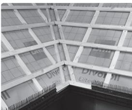
Placez la gouttière de noe Profilo-S sur les linteaux et montez-la sur les deux faces des linteaux avec des vis 4 x 30 mm, maximum 300 mm centre à centre.
