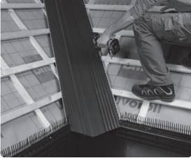
Fixez le cache-moineau sur la gouttière de noue ProfiloS, des deux côtés avec des vis 4 × 30 mm.
